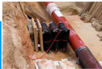
Anheben und Justieren von Kanalrohren - Bauindustrie -
